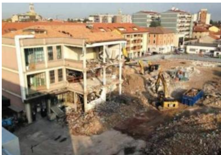
Figura 7: Attività di demolizione
