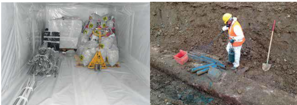
Figura 6: Attività di bonifiche amianto
