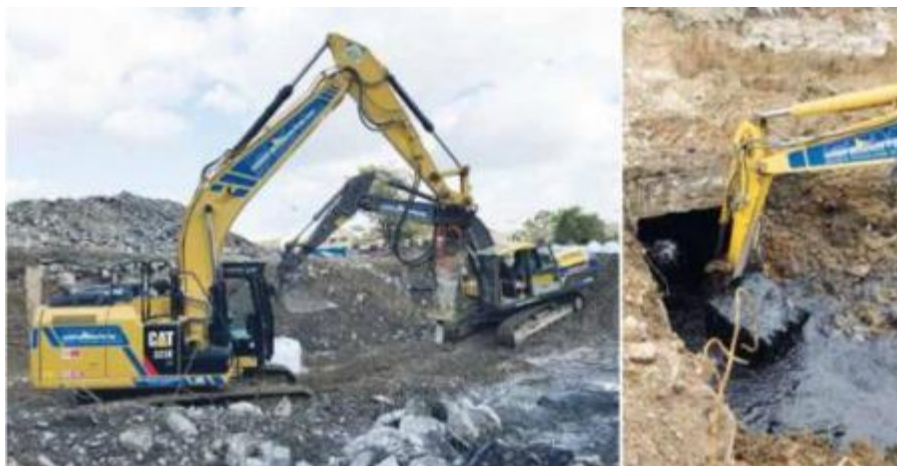
Figura 5: Attività di scavo per bonifica ambientale
